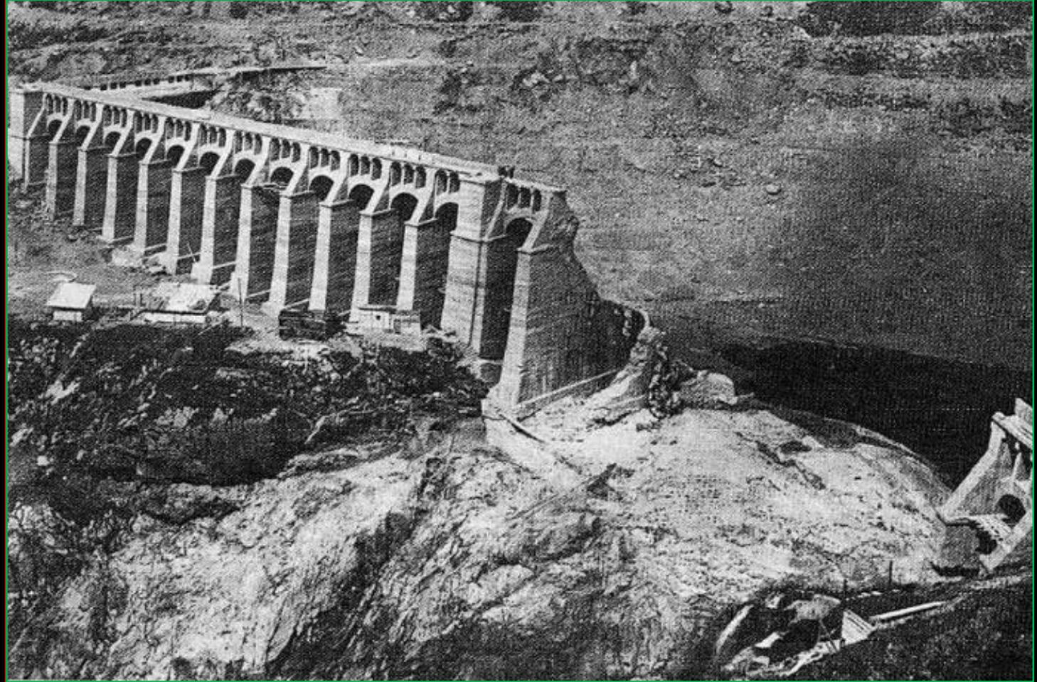
Aveva un'altezza di 56 m, una lunghezza di 260 m ed invasava 6 milioni di m<sup>3</sup> d'acqua per una superficie di 400.000 m<sup>2</sup>
