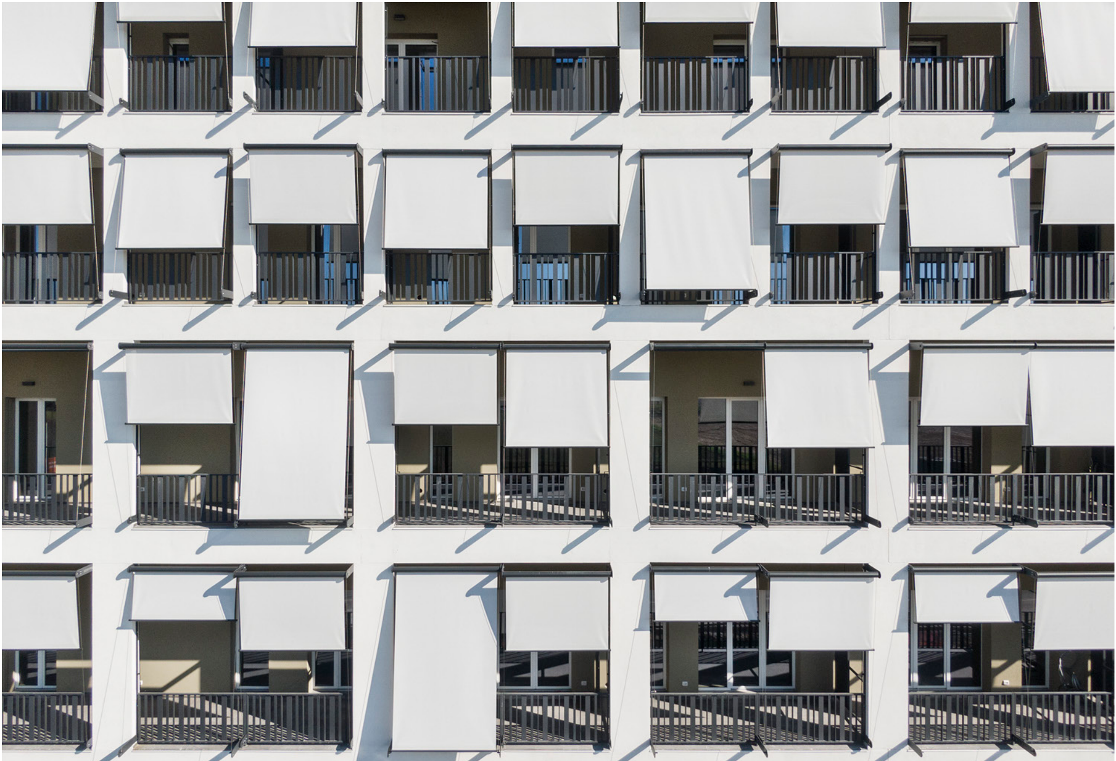
Housing Sociale 5Square. Via Antegnati, Milano
